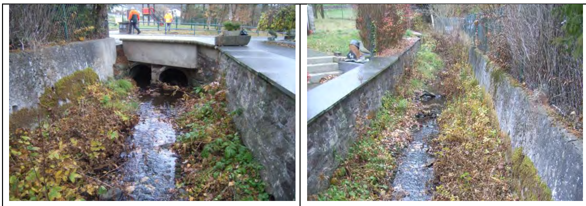
Engstelle am Rothenbach an der Querung der Rothenbachstraße; Maßnahmen: Sohlabsenkung vor Durchlass; am Ortsrand oberhalb Anlage eines Treibgutfangs und ggf. einer Rückhaltemulde; Notabflussweg über Rothenbachstraße zur Hauptstraße
