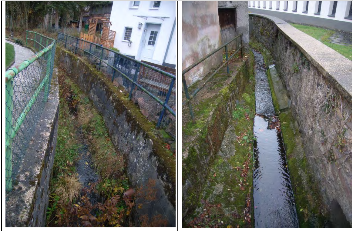
Engstellen an der Kleinen Kyll: links im Bereich Untere Layenstraße 3/5, rechts zwischen Kirche und Layenstraße 10; Maßnahmen: am Ortsrand oberhalb Bachbettauflauf, Anlage eine Treibgutfangs und ggf. einer Rückhaltemulde; Notabflussweg über Mühlenweg und Layenstraße
